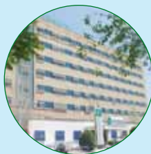
Hospital de Rehabilitación y Traumatología
