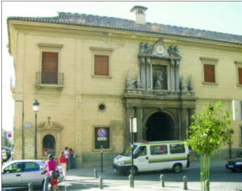
Fachada del Hospital San Juan de Dios.
