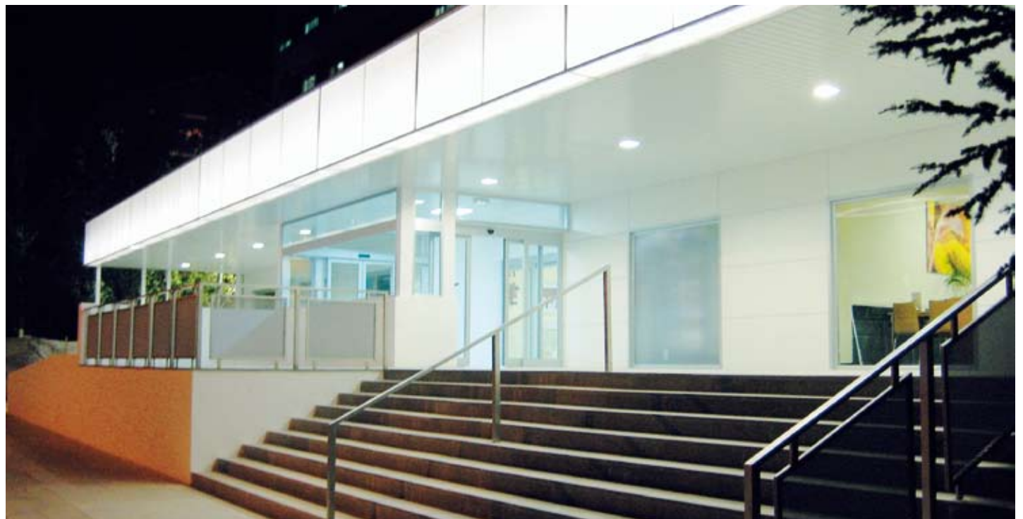
Acceso al hospital iluminado
