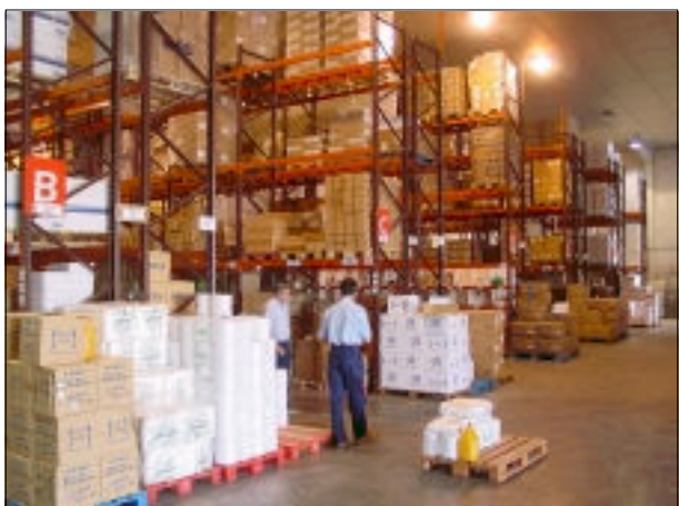
Escenas frecuentes en el almacén central en Albolote.
